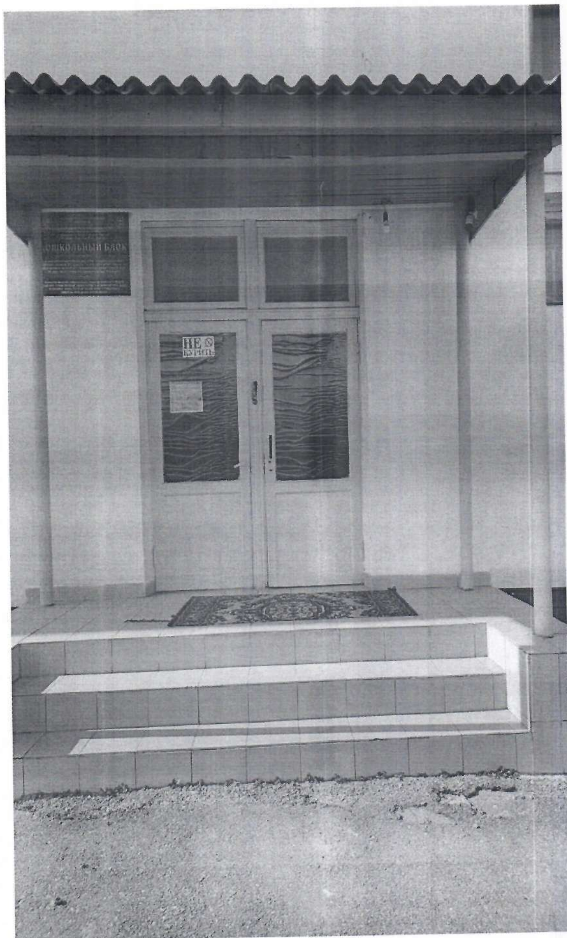
Фото 4. Входная площадка . Ступеньки (наружные)
